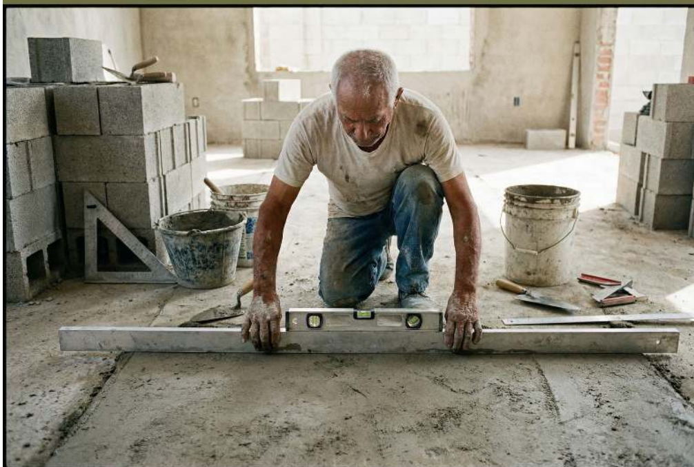
Vérification de la planéité avec une règle de 2 m et un niveau à bulle
